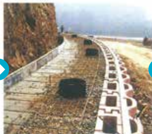
5 뒷채움 잡석 및 철근배근, 배수관 설치
